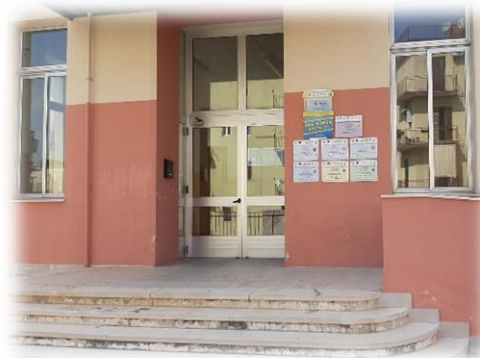
Plesso SURICO/PASCOLI SEDE UFFICI Via Mazzini, 23 Castellaneta città
